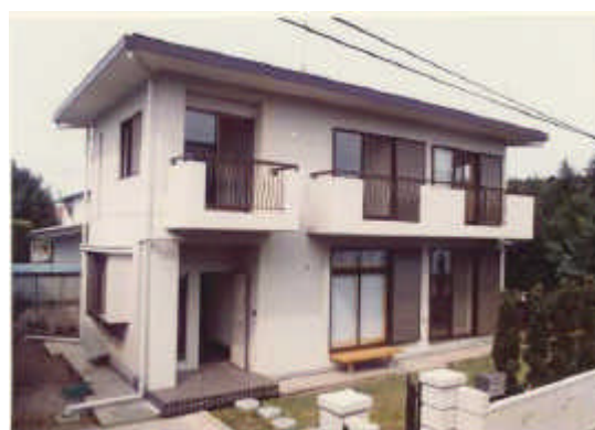
写真 2 八千代台免震住宅
