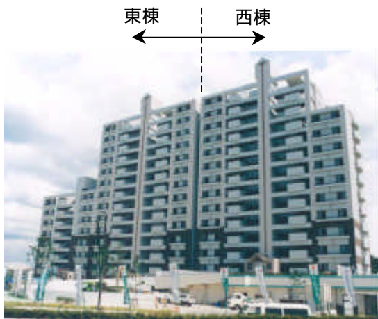
写真5 A1東棟・西棟の北側外観
