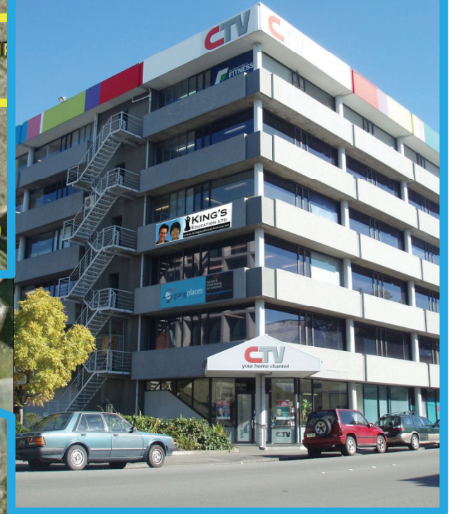
崩壊したCTVビルの大まかな位置
